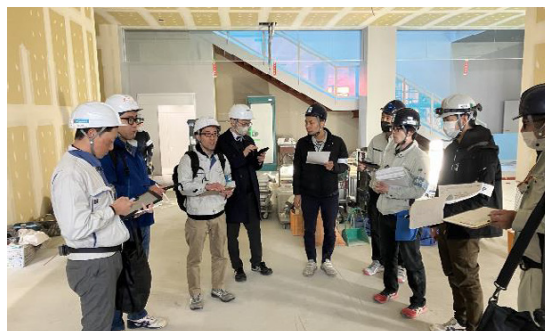
工事現場における危険予知活動の様子
