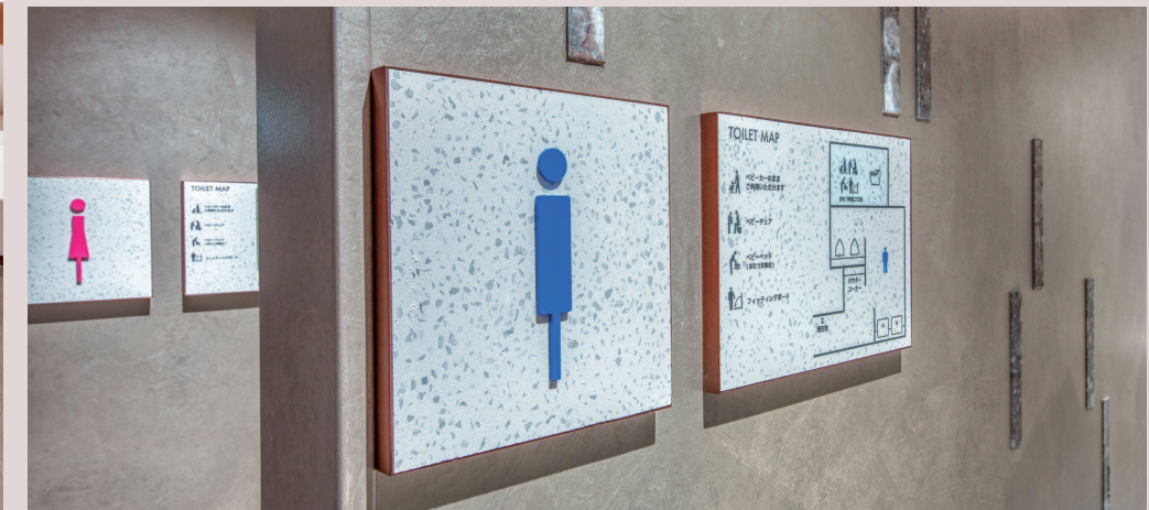
アップサイクルテラゾーをサイン盤面にも使用した。
