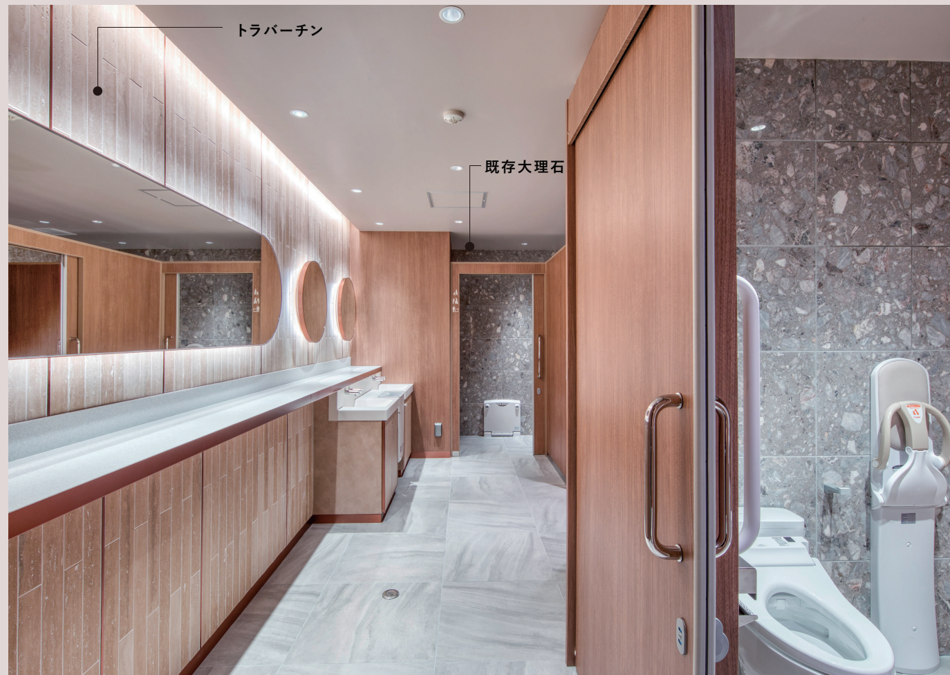
女子トイレ：アップサイクルしたトラバーチンを洗面壁面に使用。
