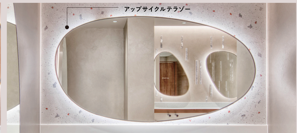
アップサイクルテラゾーを洗面壁面に使用した。
