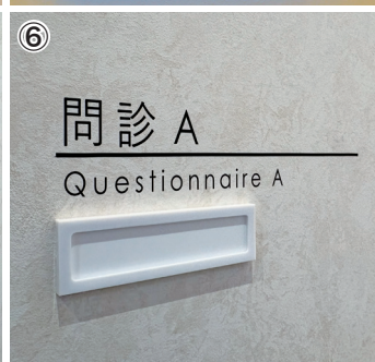
③ネオン風ピクトサイン (採尿室・化粧室) / H400×W369×D15mm ④同(問診室) / H400×W359×D15mm ベース: 12φ拡散アクリル クリア塗装 ⑤壁面誘導サイン / H90×W485×D5mm ベース: 樹脂製文字 ⑥室名サイン / H60×W240×D0.1mm 表示: マーキングフィルム 渋谷という立地特性を考慮し、室名サインは2カ国語表記を採用した。
