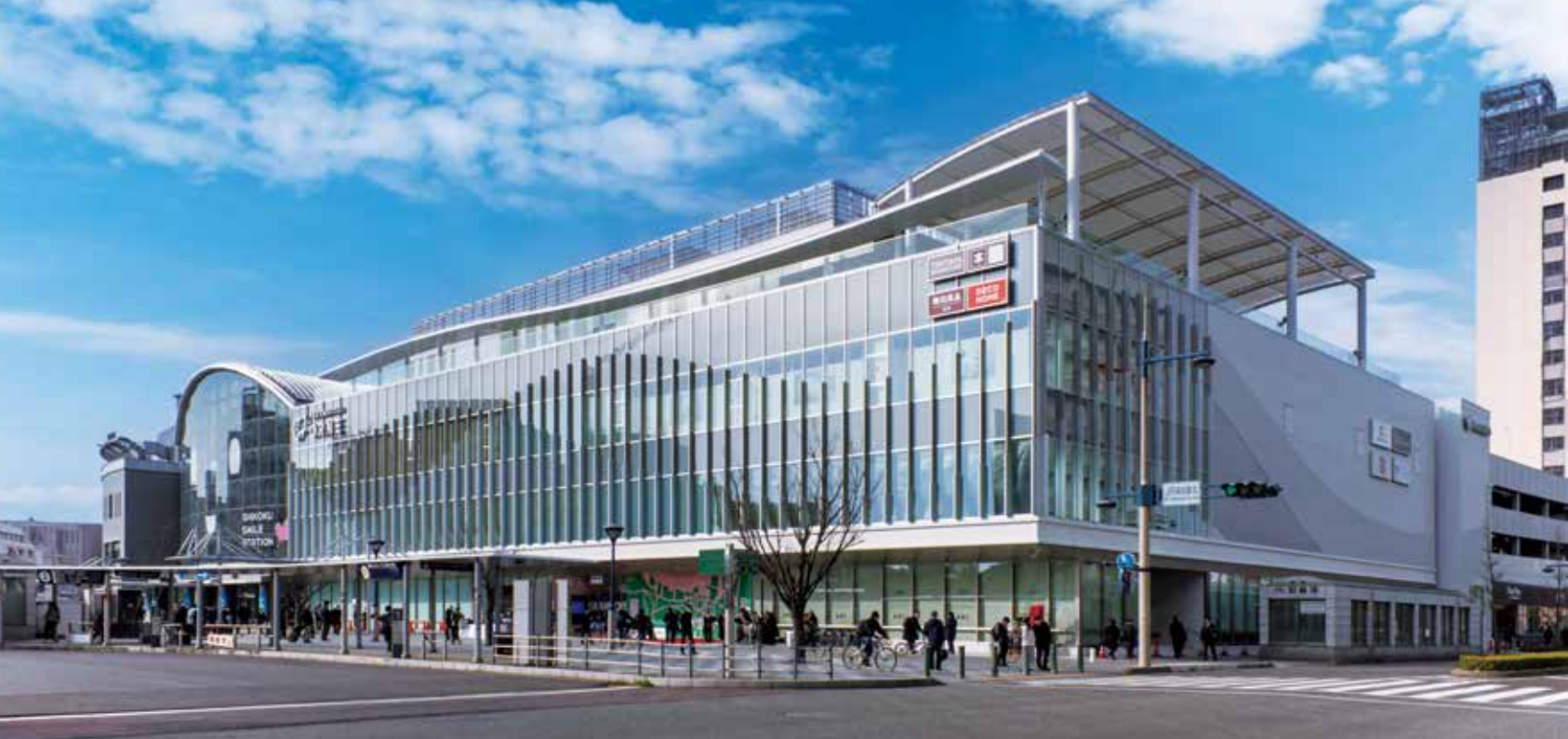
北東側交差点より望む。柔らかな曲線で構成したスカイラインとファサード
