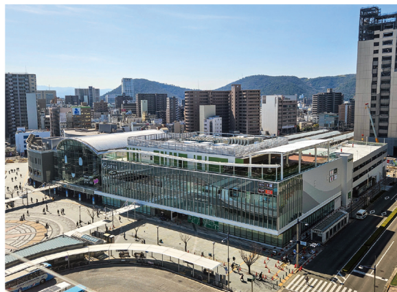
マリタイムプラザ高松屋上からの全景
