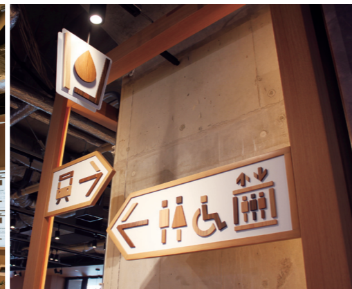
ピクトサイン (柱・木枠) 『ウォーターステーション』：H257×D5mm 『矢印・駅』：H250×W490×D5mm 『矢印・トイレ・エレベーター』：H250×W717×D5mm ピクト：合板カットアウト+染色塗装+艶消 ベース：スチール焼付塗装仕上げ 柱は、鉄道の構造躯体で直接サインを取り付けることができないため、周囲の木枠にサインを設置した。
